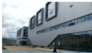
Центр IDC г. Баошань провинции Юньнань при China Unicom
